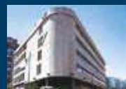
Climatisation Daikin Espagne
